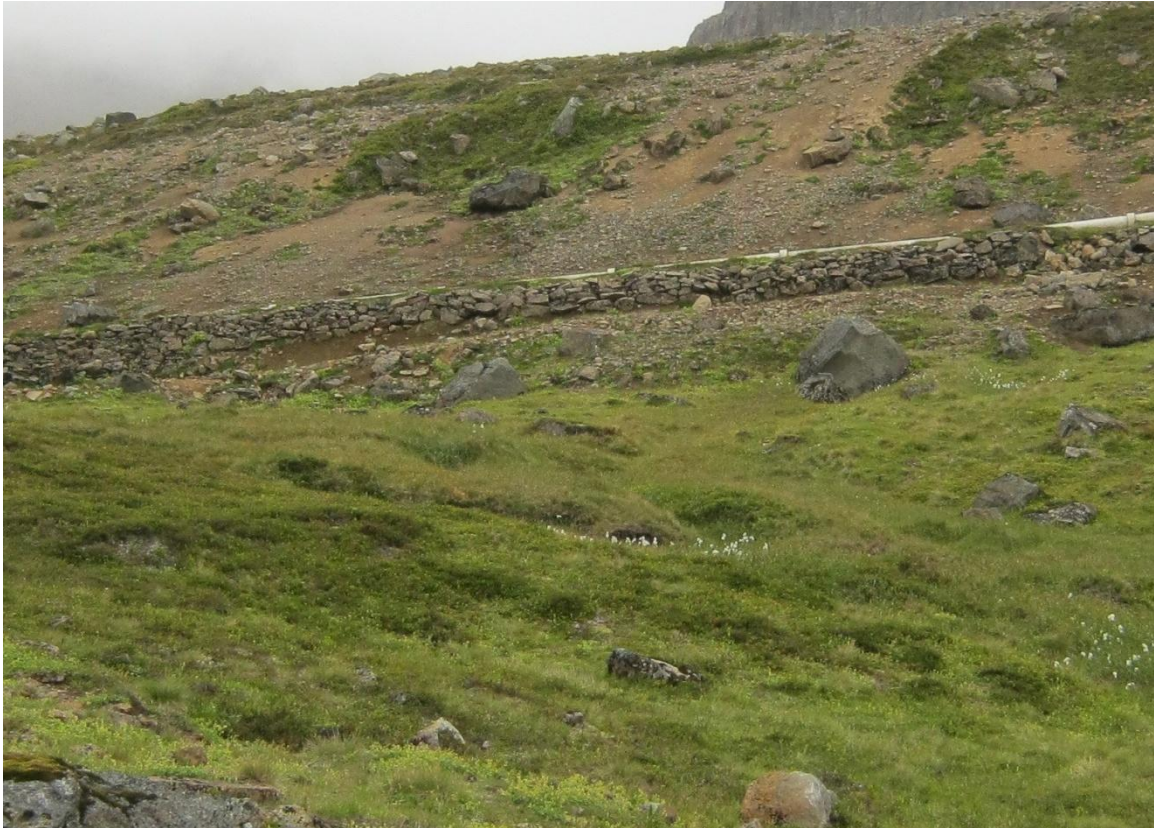
Mynd 6. Þrýstipípa og grjóthleðsla undir henni.
