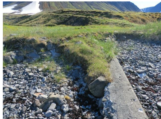
Mynd 6. Bólverk á Kaldeyri. Tekið í NA. Ljós:MHH.
