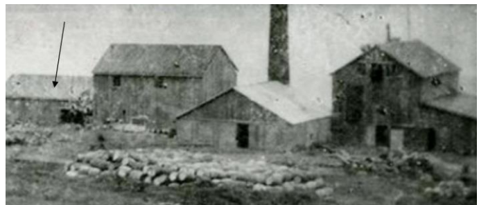
Mynd 29. Örin bendir á húsið sem grunnurinn tilheyrði líklega.
