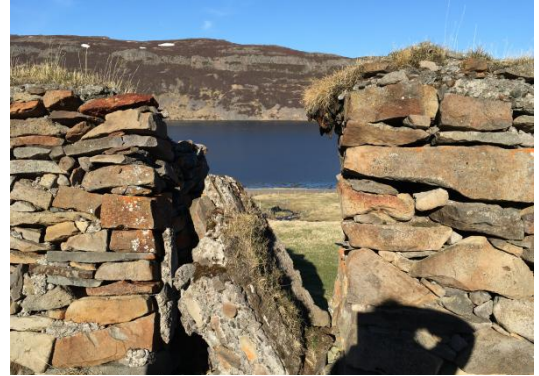
Mynd 4. Tekið inn í fjósinu og út á fjörðin. Húsið stendur að hluta og þessi veggur er óhrúnin enda steypa á milli grjótsins
